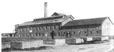
Hình 1.1: Nhà máy đường Eridania, Parma, Italy (1899)
