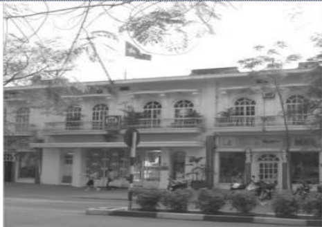
Xây dựng ban đầu
