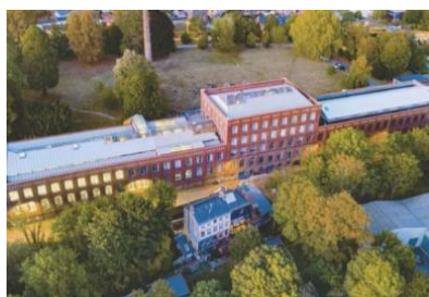
Công trình giáo dục
