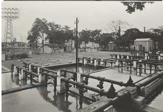
Xây dựng ban đầu
