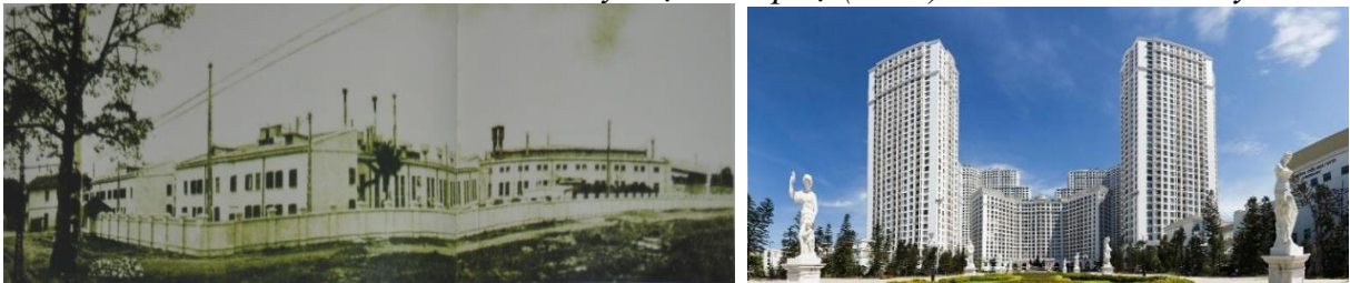
Hình 1.25: Nhà máy công cụ số 1 (~1970) - trước và sau chuyển đổi
