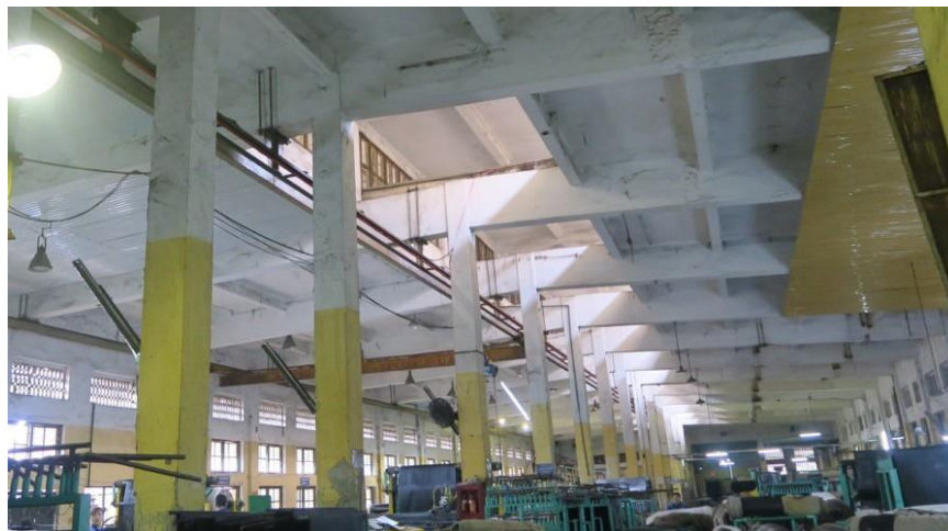
Kết cấu và thiết kế cửa mái thông gió nhà máy Cao su Sao vàng
