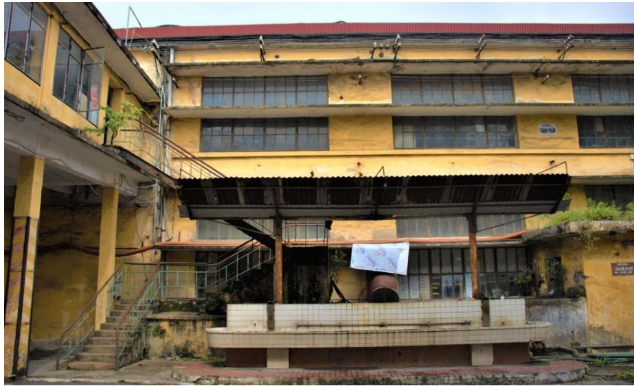
Nhà xưởng do Trung Quốc giúp xây dựng
