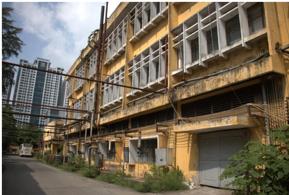
Nhà xưởng do Việt nam tự xây dựng
