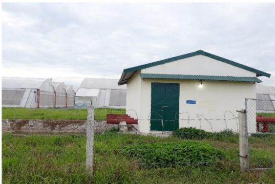
Trạm bơm tiêu nhà kính
